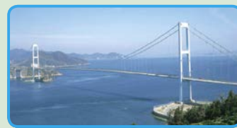
安芸灘大橋〔橋長:1,175m〕
