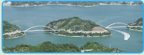
中の瀬戸大橋〔橋長:251m〕
