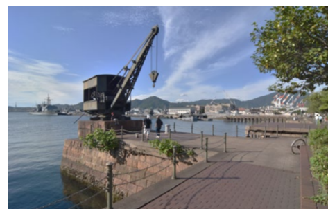
魚積積み込みクレーンの遺構。石積み護岸も美しい。
